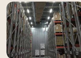
LED照明を用いた冷蔵庫内
