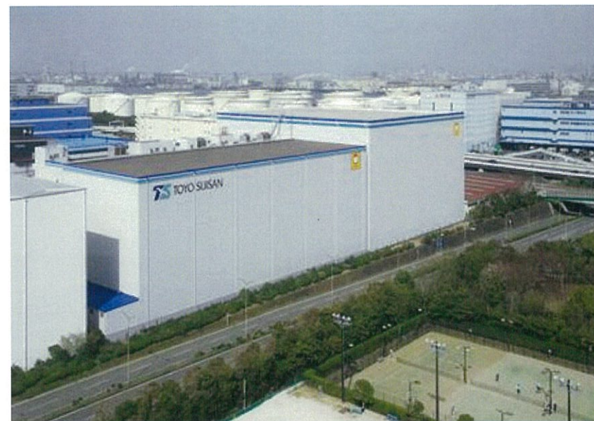
東扇島第一冷蔵庫
