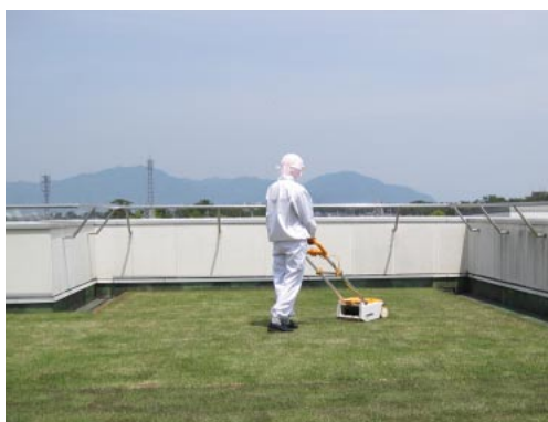
工場の屋上に完成した芝生
