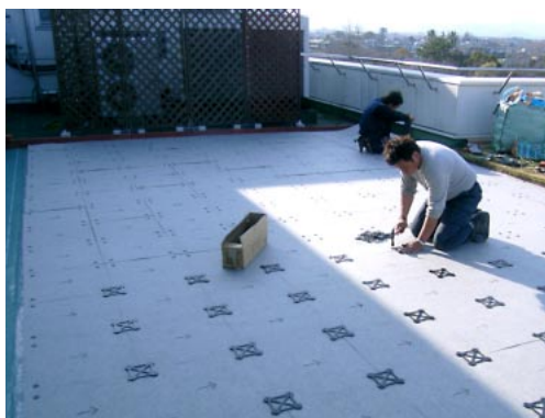
芝生化の施工(耐根シート張り)の様子
