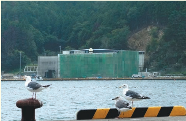
女川港対岸から望む現在の女川工場全景(8月31日撮影) 氷の生産・出荷を優先したため、外壁は依然工事が行われている
