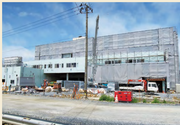
復旧工事中の石巻工場
