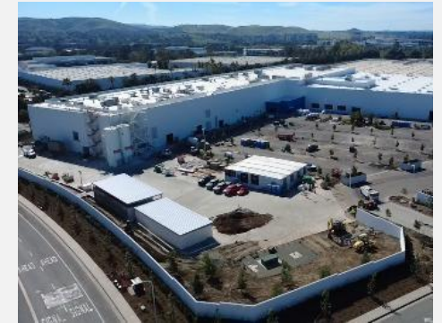
2026年度稼働予定のラグナ新工場
