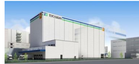
新神戸冷蔵庫 約28千トン
