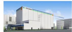
新神戸冷蔵庫 約28千トン
