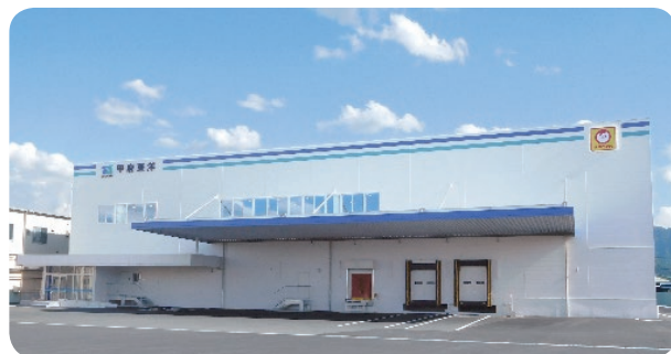
所在地：山梨県中央市布施91 稼働：2018年1月
