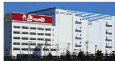
東扇島第二冷蔵庫
