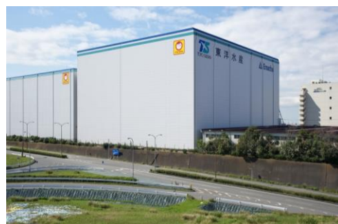
東扇島第一冷蔵庫
