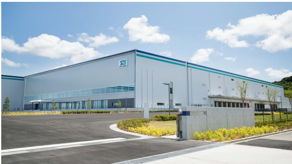
関西工場 外観写真
