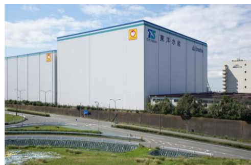
東扇島第一冷蔵庫
