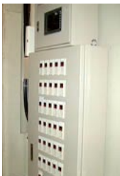
電力監視システム
