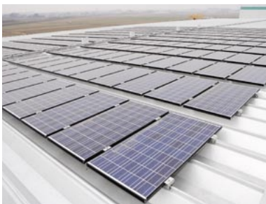
物流棟屋根上の太陽光パネル
