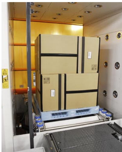
資材を回転させながら風を吹きつけ、異物を除去します
