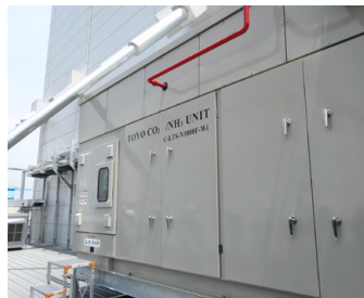
自然冷媒を利用した 冷凍機
