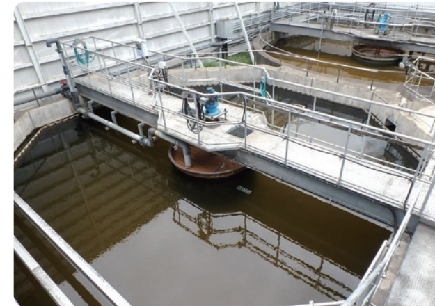
埼玉工場の排水処理設備
