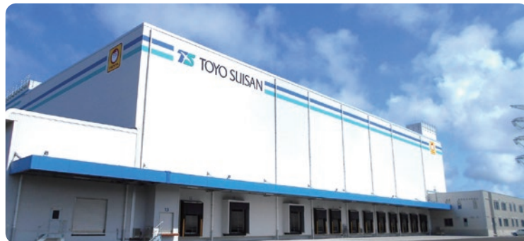
2020年4月より稼働した石狩新港物流センター（自然冷媒を採用）
