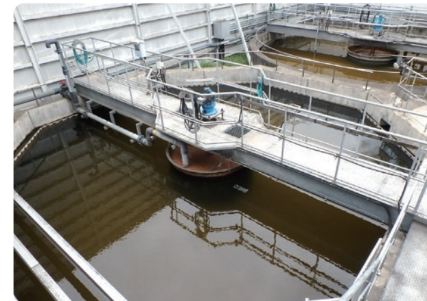
埼玉工場の排水処理設備
